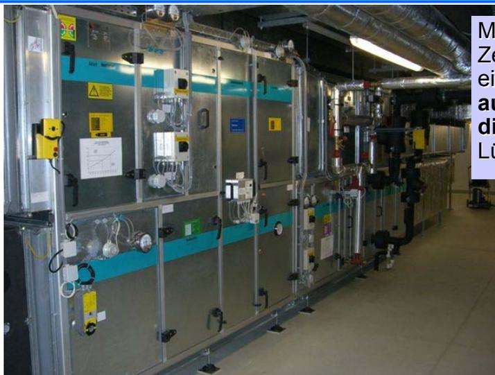
Modernes RLT-Zentralgerät in einer **ausreichend dimensionierten** Lüftungszentrale
