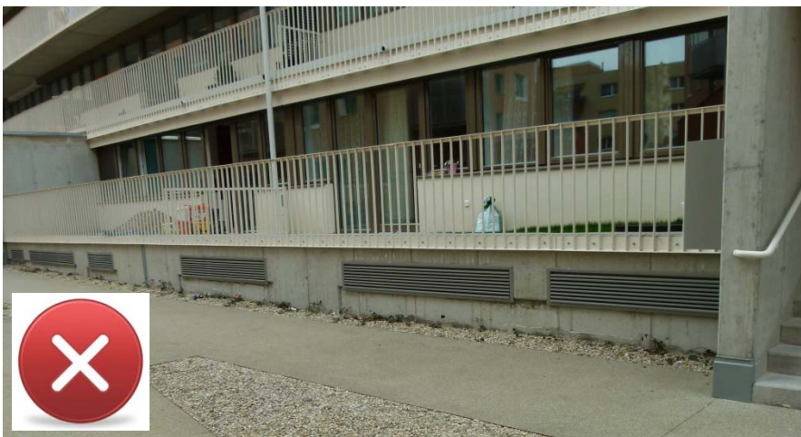
Oben: Außenluftansaugung 30 cm über Gelände Unten: „Verlorene Schalung“ im Außenluftschacht
