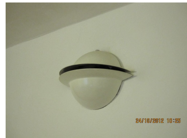
Oben: Zuluft Weitwurfdüse Unten: Zuluftdurchlass bodenintegriert
