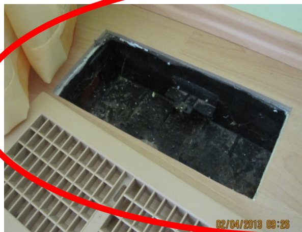
Oben: Feiner Staubbelag in Zuluftleitung (11 Jahre Betrieb) Unten: Zuluftdurchlass bodenintegriert
