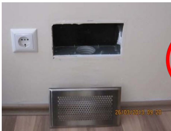
Oben: Feiner Staubbelag in Zuluftleitung (6 Jahre Betrieb) Unten: Luftdurchlass Mauerwerk
