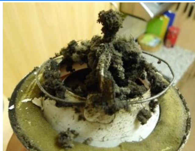
Oben: Abluftventil mit Staub-/ Flusenbelag
