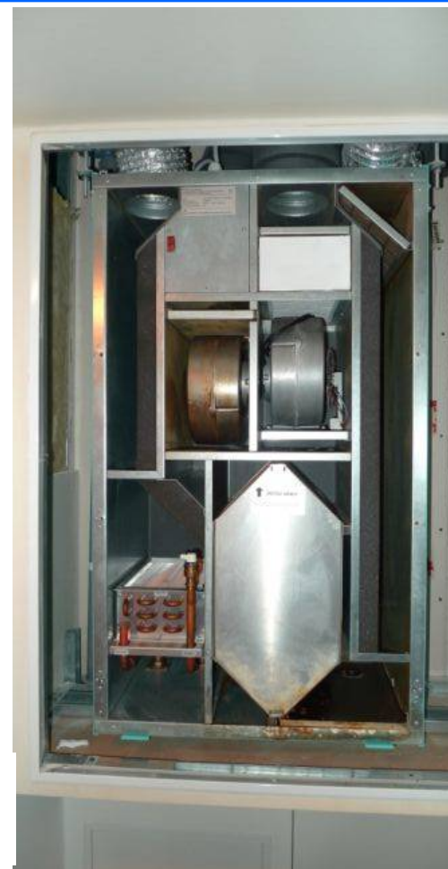
Dezentrales Gerät: Gute Zugänglichkeit, einfache Wartung und Austauschbarkeit von Komponenten
