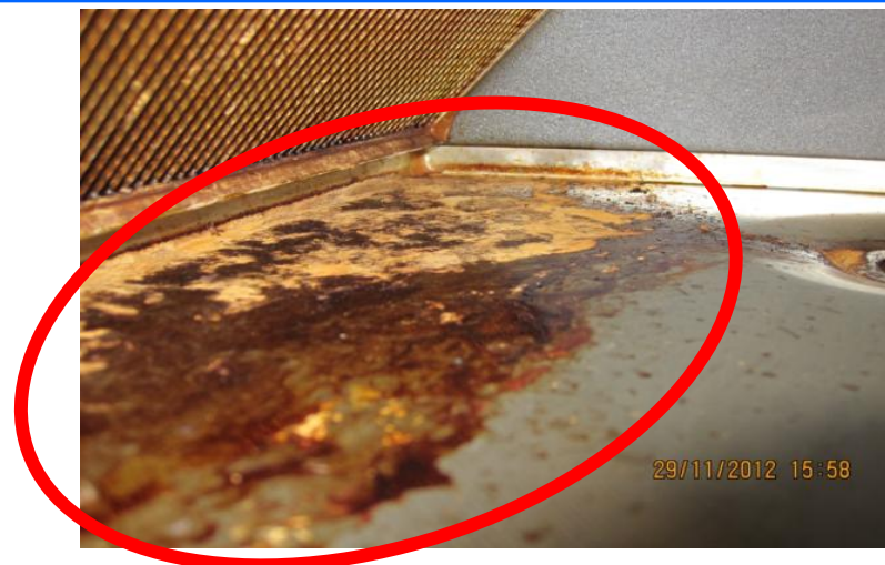
Oben: Blick ins Lüftungsgerät einer Raucherwohnung Unten: Verfärbung Ventilator
