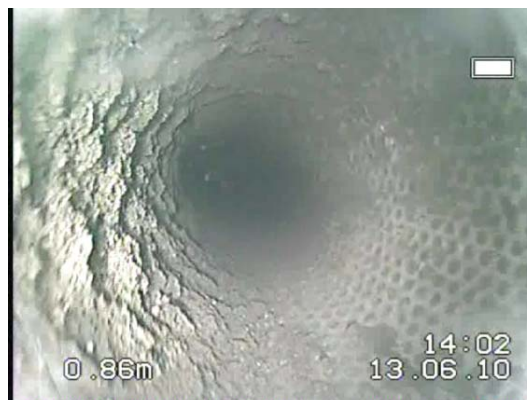
Abluftleitung, Schalldämpfer
