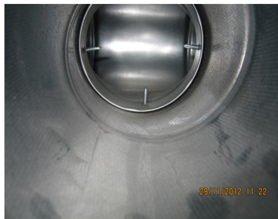
Oben: Feiner Staubbelag in Zuluftleitung (11 Jahre Betrieb) Unten: Zuluftdurchlass bodenintegriert
