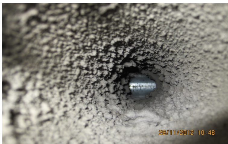
Oben: Abluftventil mit Staub-/ Flusenbelag
