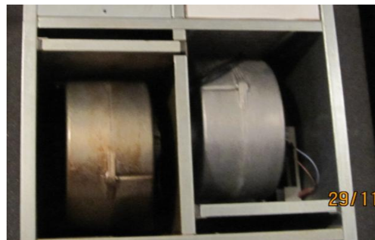
Oben: Blick ins Lüftungsgerät einer Raucherwohnung Unten: Verfärbung Ventilator
