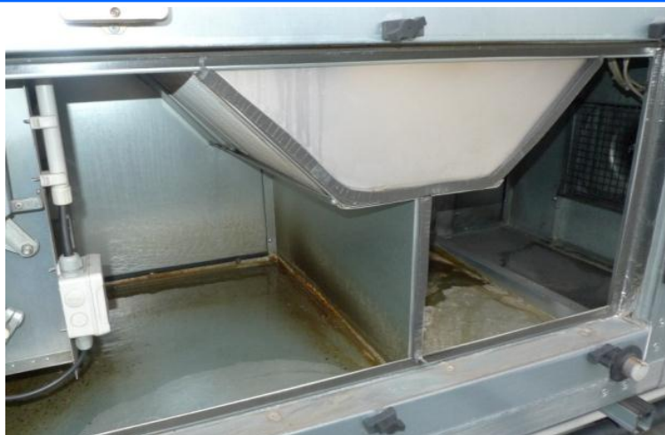
Oben: Wassereintritt im Lüftungsgerät, Kondensatablauf nicht angeschlossen Unten: Staubablagerungen im Gerät
