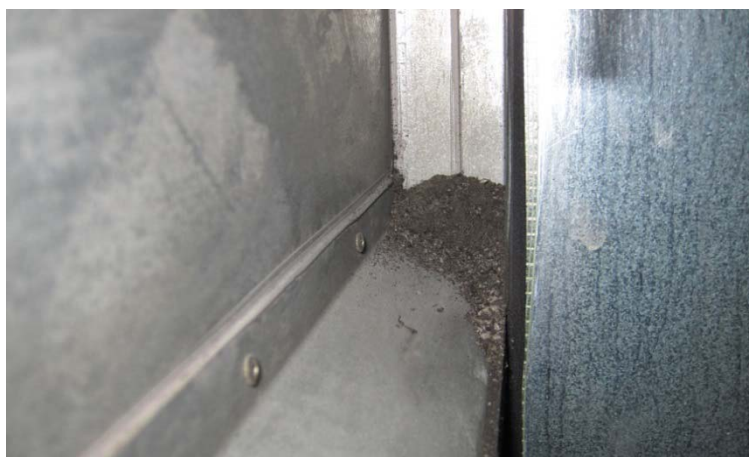
Oben: Wassereintritt im Lüftungsgerät, Kondensatablauf nicht angeschlossen Unten: Staubablagerungen im Gerät
