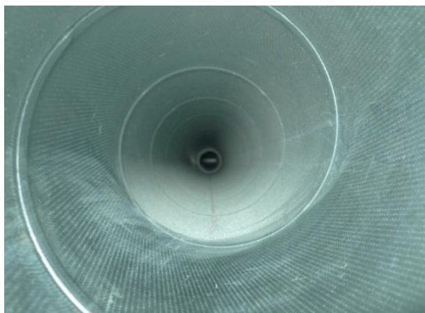
Oben: Feiner Staubbelag in Zuluftleitung (6 Jahre Betrieb) Unten: Luftdurchlass Mauerwerk
