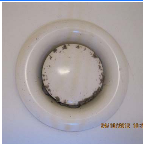
Oben: Abluftventil mit Staub-/ Flusenbelag
