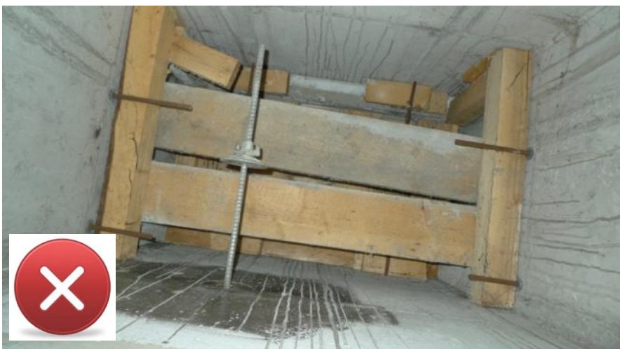
Oben: Außenluftansaugung 30 cm über Gelände Unten: „Verlorene Schalung“ im Außenluftschacht
