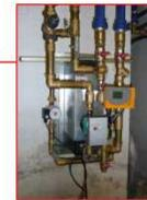
Frischwassermodule mit patent. niedrigem RL. keine Zirkulation notwendig
