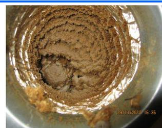
Oben: Abluftventil mit Staub-/ Flusenbelag
