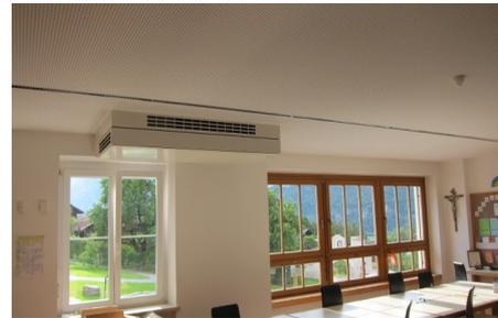
Außen-/Fortluftdurchführung durch die Außenwand    Geräte halb in der Deckenabhängung
